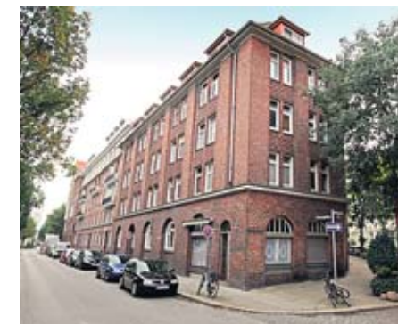
In diesem Haus an der Rehhoffstraße plant der Investor kleine Apartments
